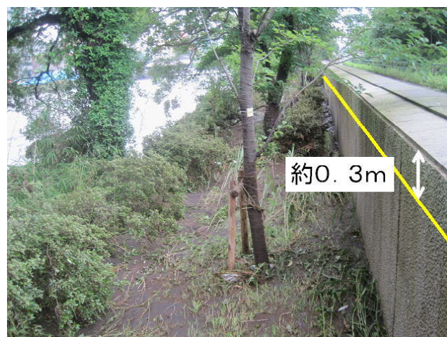
右岸(メルパルク)側では堤防上端から約0.3mまで増水 2012年7月12日撮影
