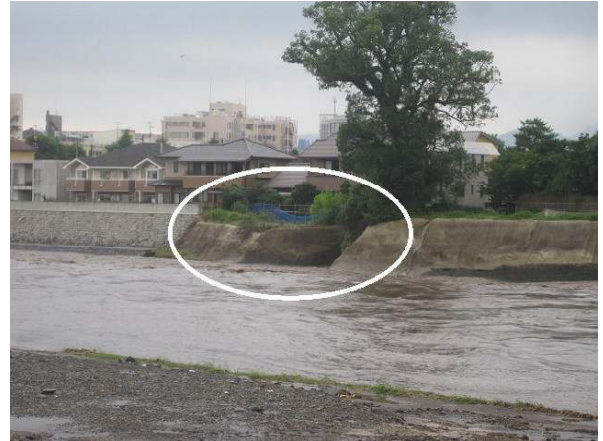
右岸(藤崎宮)側の堤防が切れている箇所から浸水 2012年7月12日撮影
