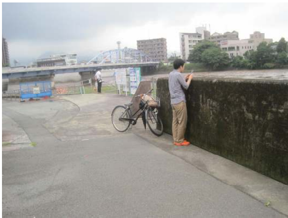
堤防が切れている子飼橋上流の左岸 2012年7月12日撮影
