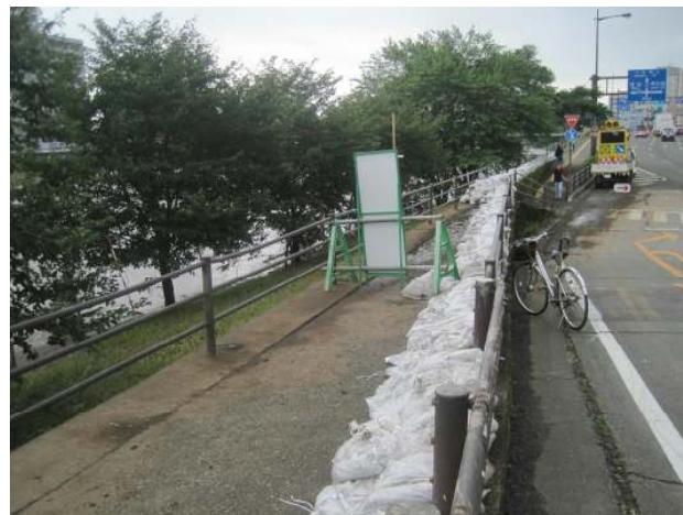
土のうが積まれた右岸側(国道3号) 2012年7月12日撮影
