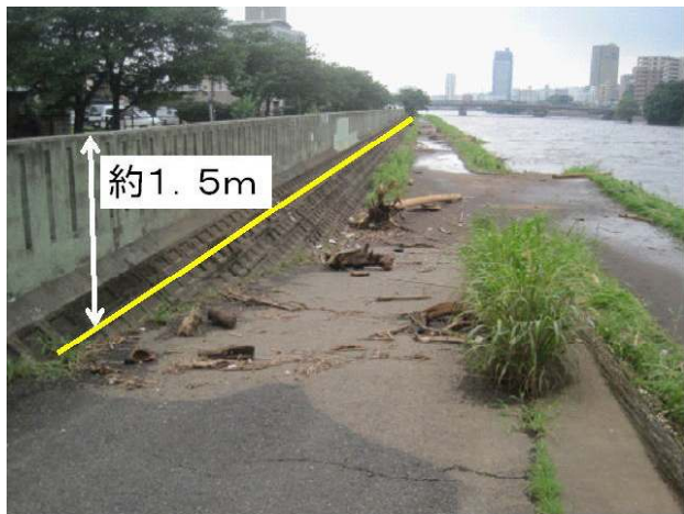
左岸(大学病院)側では堤防の上端から1.5m程度の余裕 2012年7月12日撮影
