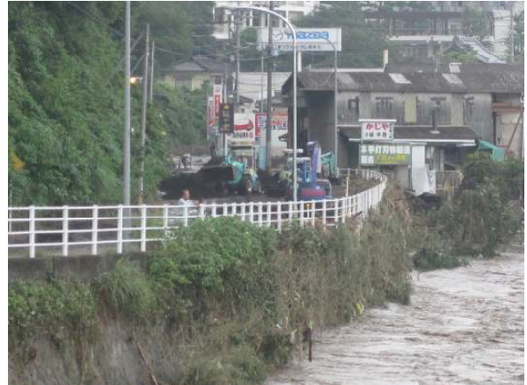
浸水し土砂が大量にたまった県道337号(右岸側) 2012年7月12日撮影
