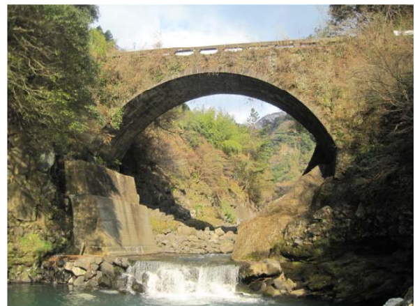
流失前の黒川橋(1900年完成) 2011年12月18日撮影
