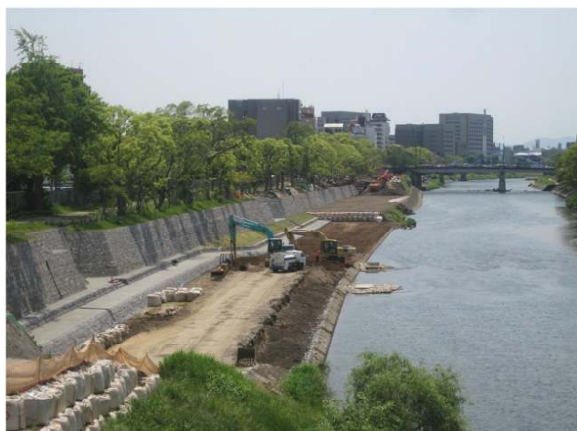
左岸(白川小学校)側の改修工事は未完成 2012年5月12日撮影
