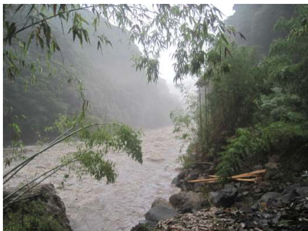
立野ダム本体予定地右岸側の工事用道路が流失
