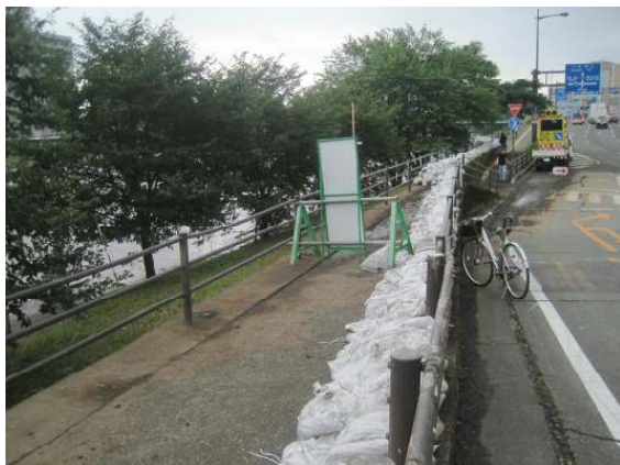
土のうが積まれた右岸側（国道3号）
