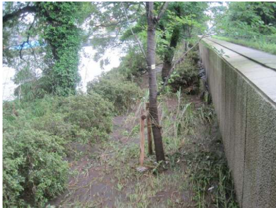
右岸側では堤防上端から0.3m程度の余裕
