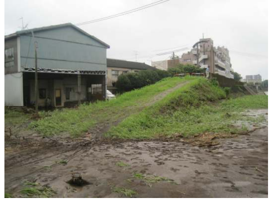
堤防が切れている竜神橋下流の左岸から浸水
