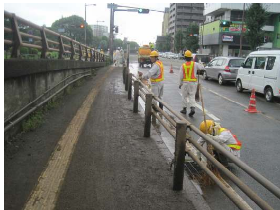
浸水した国道3号
