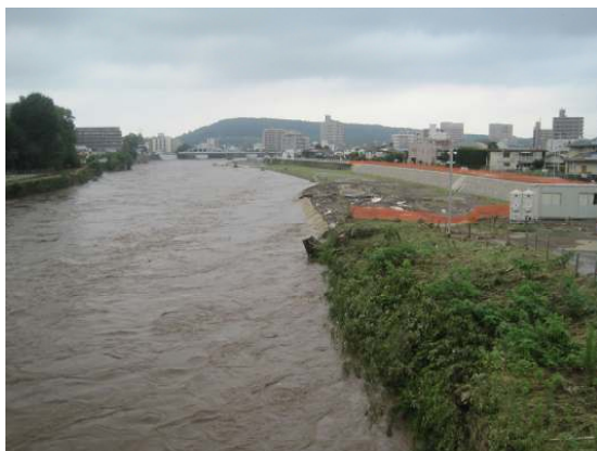
明午橋の未改修が水位上昇の要因
