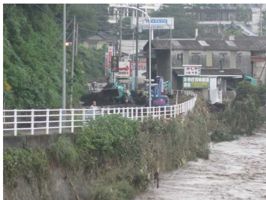
浸水した県道337号（右岸側）
