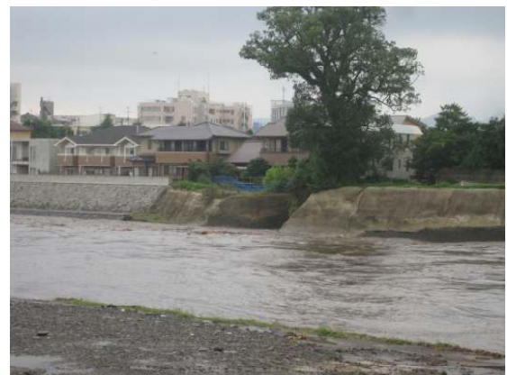
右岸側の堤防が切れている箇所から浸水
